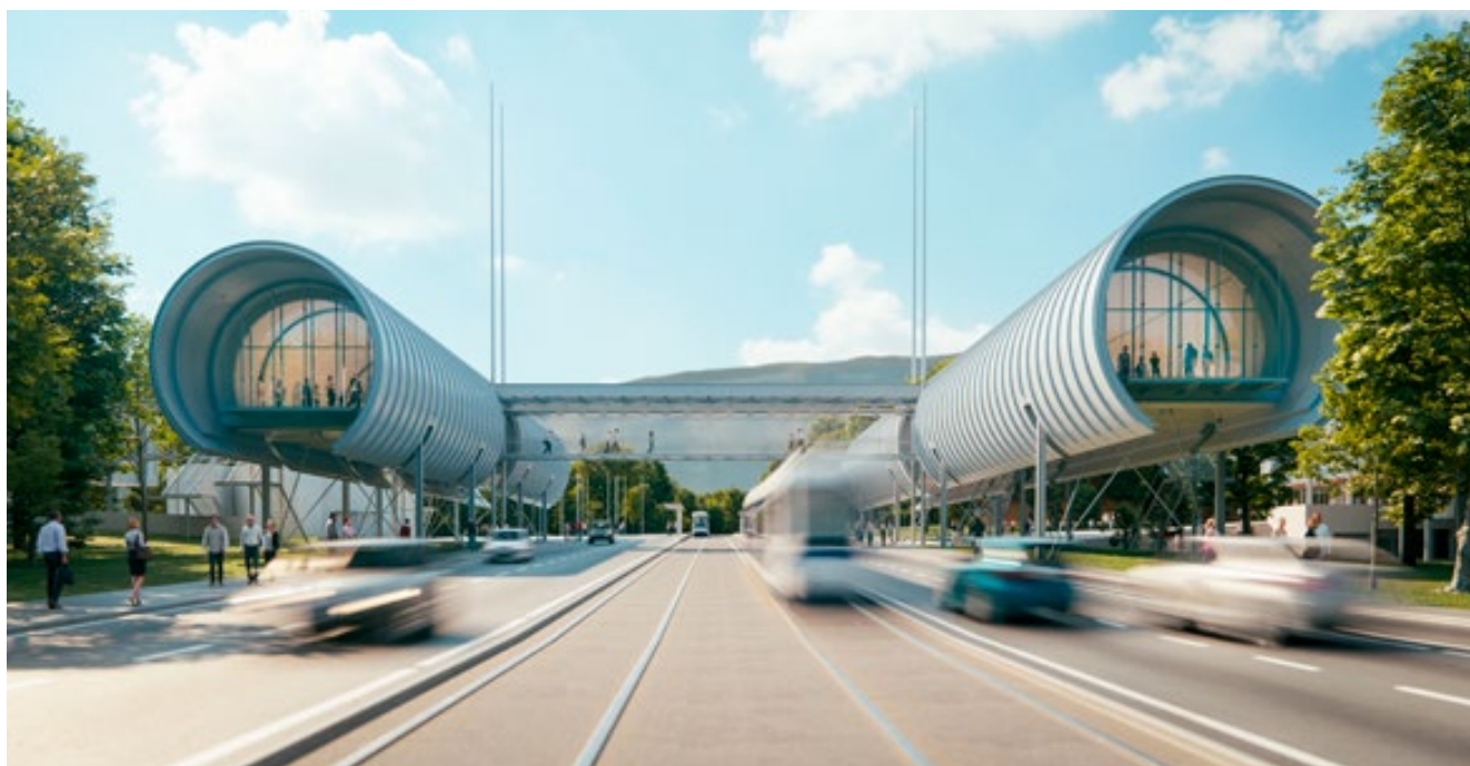
CERN's new science portal / Portail des sciences du CERN
